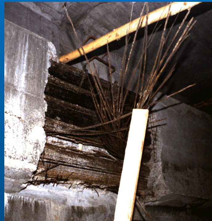
Gerissene Spannlitzen Innbrücke Kufstein
