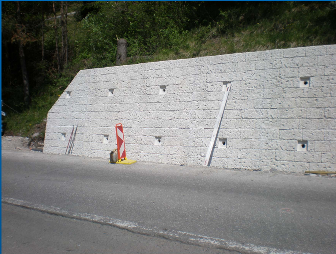
Fertigteilplatten für eine verankerte Hangstützung
